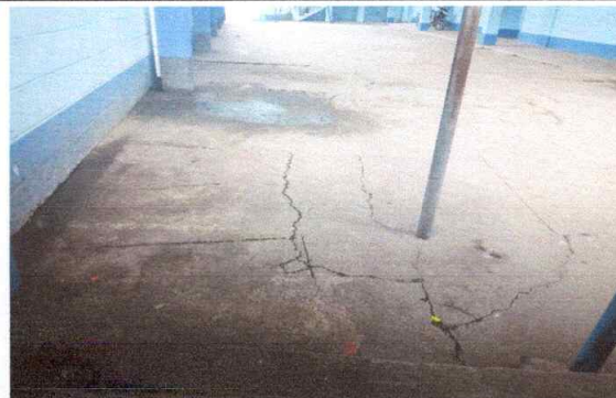
Foto 2: Sustitución de piso torta de concreto (Patio)
