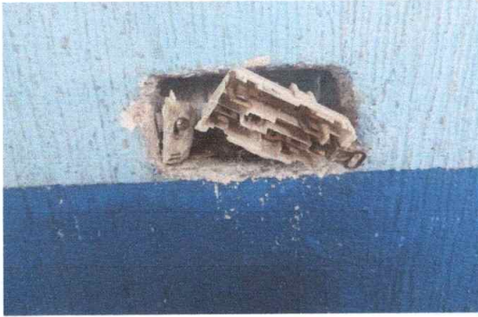
Foto 7: Sustrucción de tomacorrientes dobles
