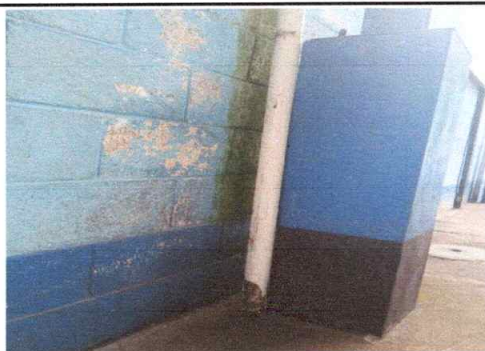
Foto 5: Bajadas de aguas pluviales
