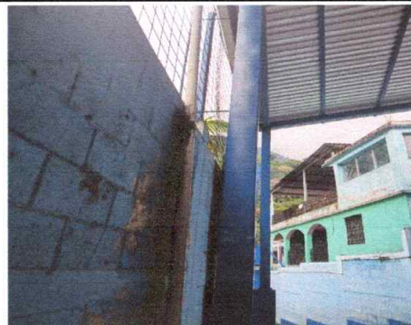
Foto 4: Reparación de bajada de agua pluvial
