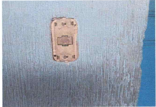
Foto 8: Sustrucción de interruptores simples
