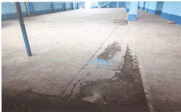
Foto 1: Sustitución de torta de concreto (Patio)
